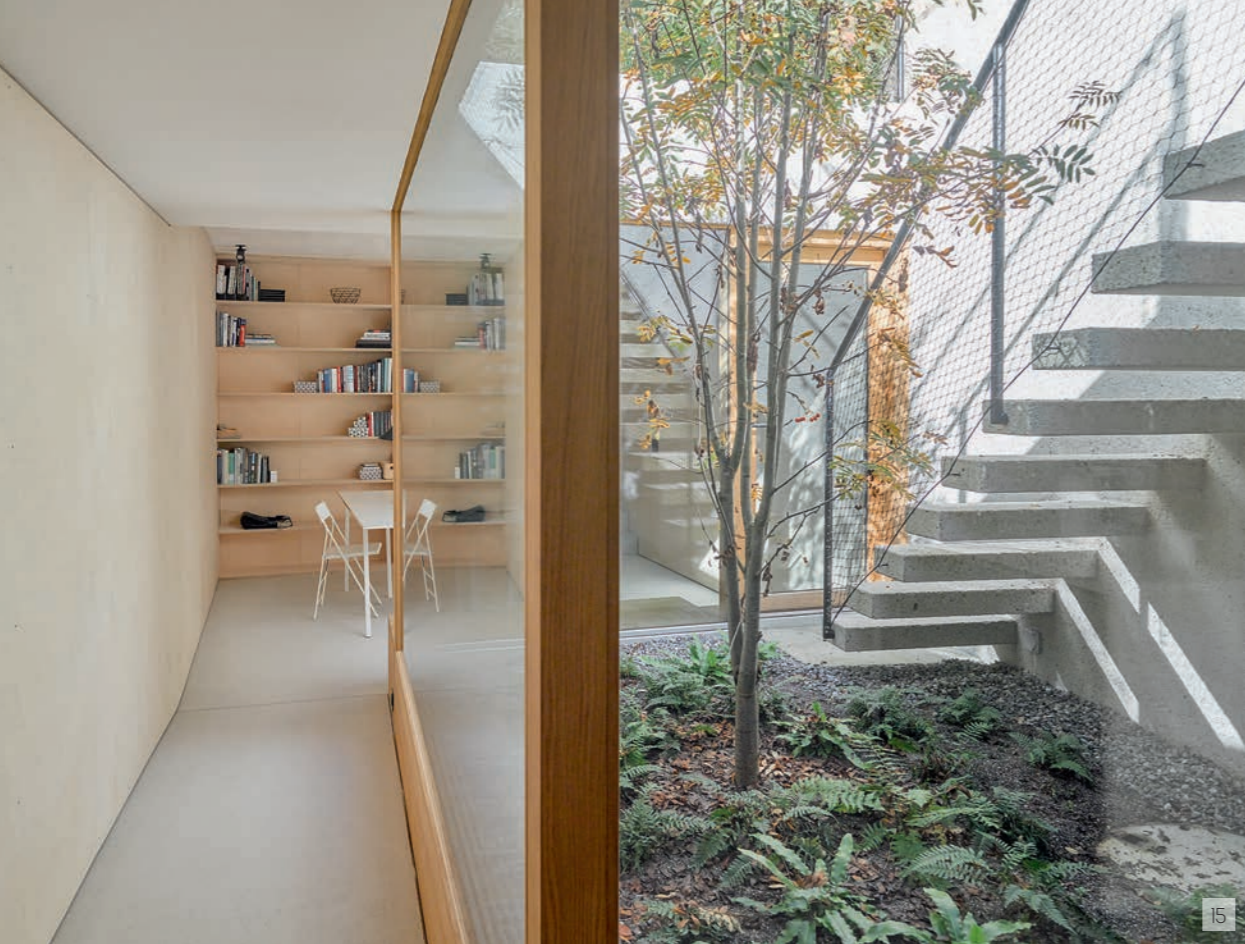
15 Das neue Untergeschoss, in dem sich das Atelier und die Werkstatt befinden, ist aus Beton errichtet.
